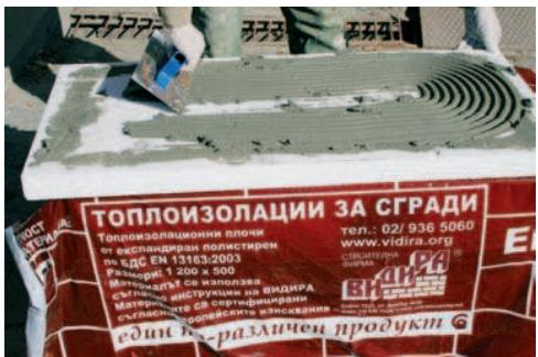
При равни и гладки повърхности, може да се прилага с гребен, със зъби 10x10 mm. Лепилото се нанася върху цялата повърхност с гребен.
