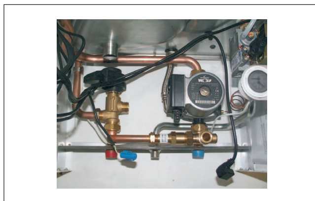
Снимка: Демонтиран разпределителен блок
