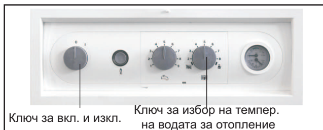
Снимка: Общ изглед управление
