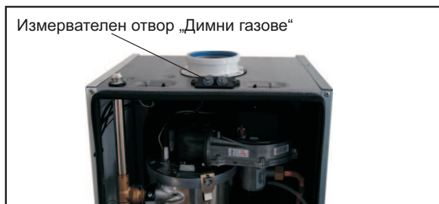
Снимка: Измерване на димни газове при отворен котел
