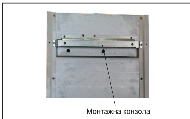
Снимка: Монтирана монтажна конзола за котела
